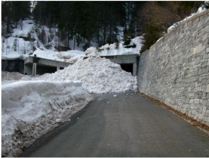
*Abb. 7: Verschüttete Strasse zwischen Piano di Campo und Campo, Vallemaggia, TI. Lawinenschnee drang in die Galerie ein und floss trotz dieser auch auf die Strasse (Foto: F. Piazzini, 02.03.2009).*
