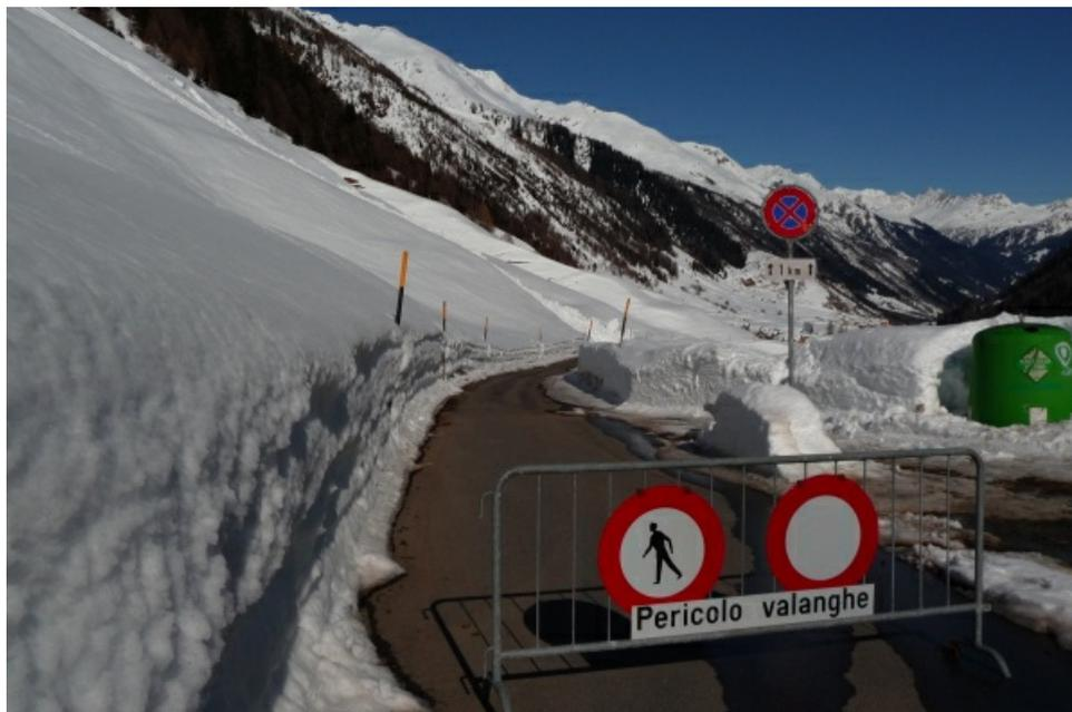
Abb. 6: Die grossen Schneemassen, welche vor allem am Alpensüdhang auch in mittleren Lagen noch vorhanden sind, konnten bei zunehmender Durchfeuchtung auf die Strasse abgleiten. Zwischen Ronco und Bedretto, rund 1500 m, TI verschüttete eine solche Lawine die gesperrte Strasse (Foto: L. Silvanti, 28.02.2009).
