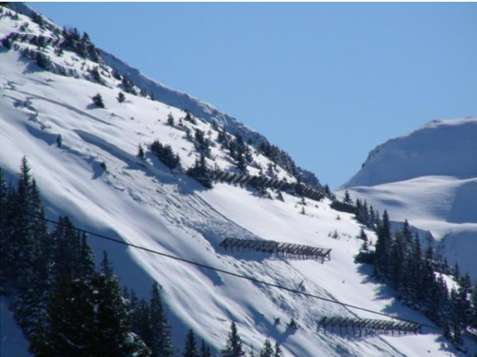
Gleitschneelawine am Mattjisch Horn (Schanfigg, GR) auf etwa 2000 m an einem Südwesthang. Links oben im Bild, über dem Anriss, sind weitere Risse zu sehen. Die primäre Funktion dieser Lawinverbauungen ist einen grösseren Anriss zu verhindern und nicht - wie hier - abgeglittenen Schnee aufzufangen (Foto: M. Balzer, 25.02.2009).
