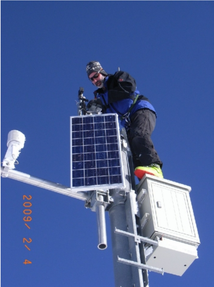
Reparaturarbeiten an einer IMIS-Windstation. Defekte Sensoren werden so rasch wie möglich ersetzt, damit die lokalen Sicherheitsverantwortlichen auf zuverlässige Messwerte zählen können (Foto: P. Caviezel).
