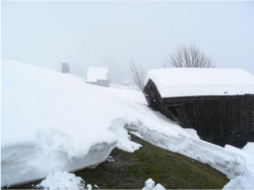
Abb. 3: Gleitschneelawinen überführten Strassen und beschädigten Ställe u.a. im Gebiet Valzeina im vorderen Prättigau. Das Schicksal des Stalles ist ungewiss. Die Rundholzbauten haben eine gute Stabilität. Gegen Gleit- oder Nassschneelawinen können aber solche Bauten nicht bestehen (Foto: M. Balzer, 21.12.2008).
