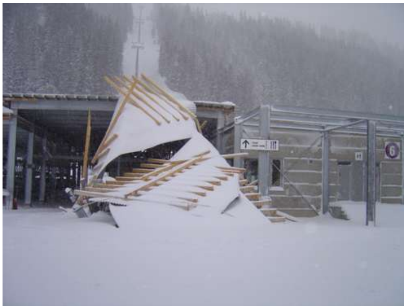
Abb. 8: Bei einer Talstation einer Sesselbahn wurde durch den Sturm das Dach abgehoben (Foto: Gian Darms, Ruschein).
